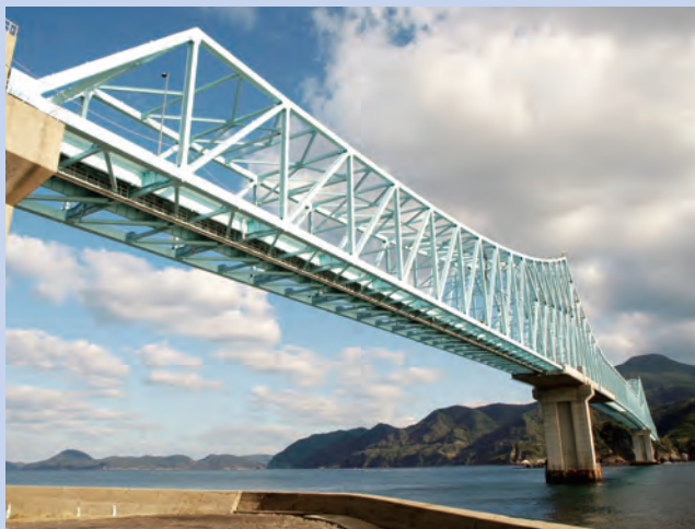
■受注先 県北振興局 ■工事名 生月大橋橋梁塗装工事 ■竣工 平成 30 年 2 月
