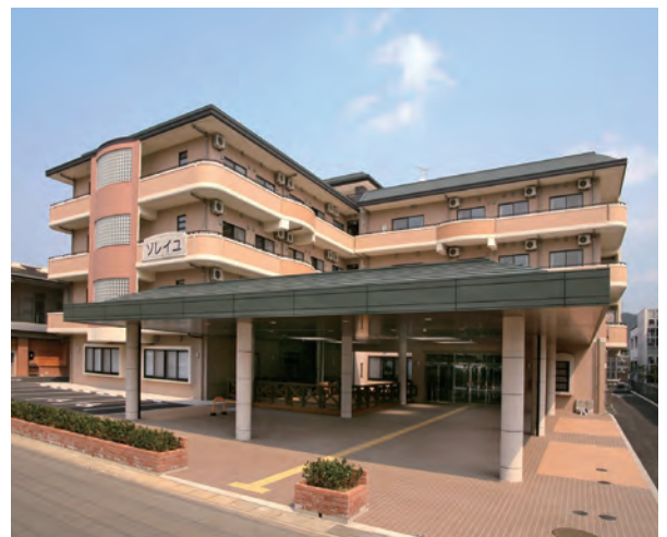
■受注先 社会福祉法人 豊寿会 ■工事名 養護老人ホームソレイユ 改築工事 ■竣工 平成 24 年 2 月
