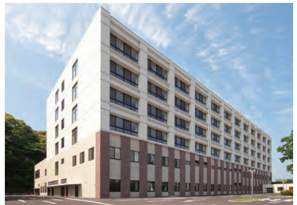
■受注先 国立病院機構 長崎川棚医療センター ■工事名 長崎川棚医療センター 外来管理棟・病棟建替整備工事 ■竣工 平成 29 年 6 月
