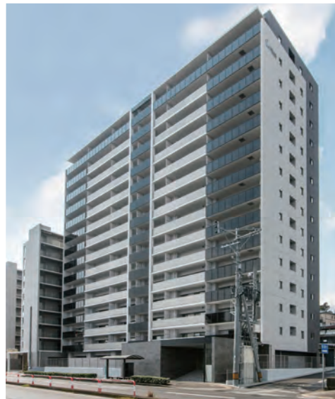
■受注先 第一交通産業株式会社 ■工事名 アーバンパレス諫早駅新築工事 ■竣工 令和 7 年 3 月
