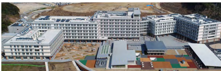
■受注先 国立大学法人 九州大学 ■工事名 九州大学 (伊都) 総合教育研究棟 (人文社会科学系) 新営工事 ■竣工 平成 30 年 2 月
