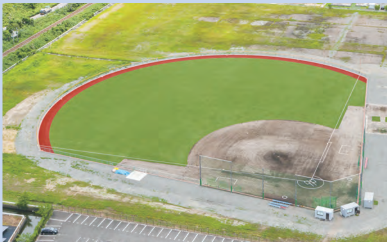
■受注先 学校法人九州文化学園 ■工事名 長崎国際大学野球場建設工事 ■竣工 平成 27 年 5 月
