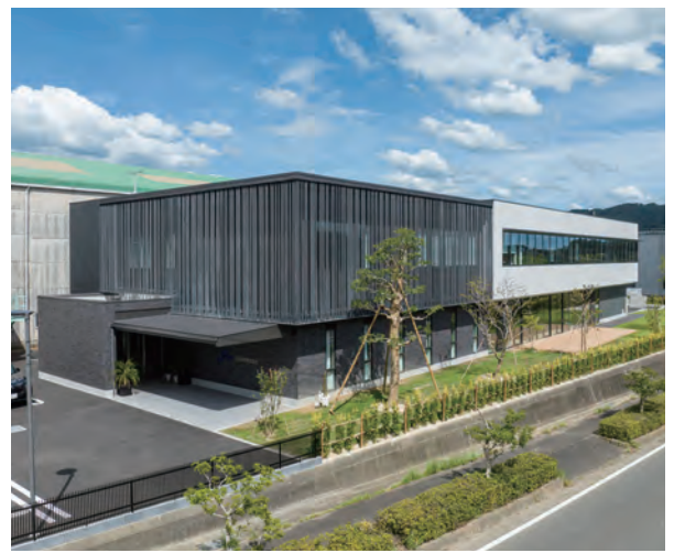
■受注先 大阪鋼管株式会社 ■工事名 大阪鋼管事務所本館建替工事 ■竣工 令和 6 年 8 月
