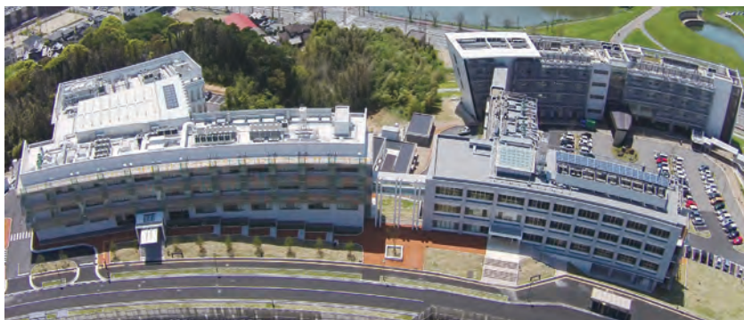
■受注先 国立大学法人 九州大学 ■工事名 共進化社会システムイノベーションセンター カーボンニュートラル・エネルギー国際研究所 第 2 研究棟 先導物質科学研究所 ■竣工 令和 27 年 1・2 月
