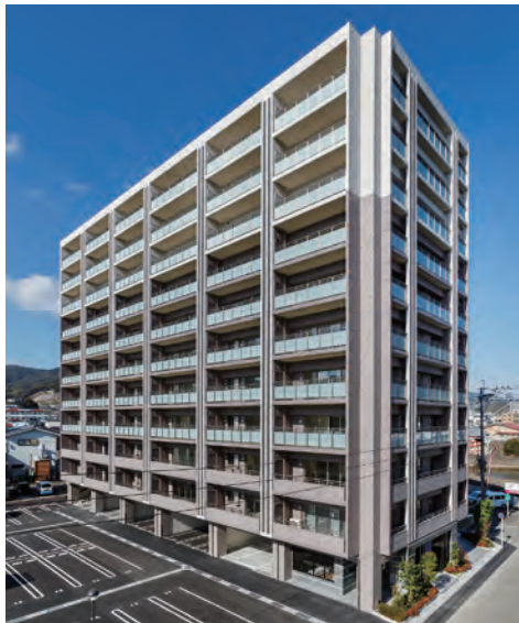
■受注先 作州商事株式会社 ■工事名 エイルマンション東長崎 新築工事 ■竣工 令和元年 12 月
