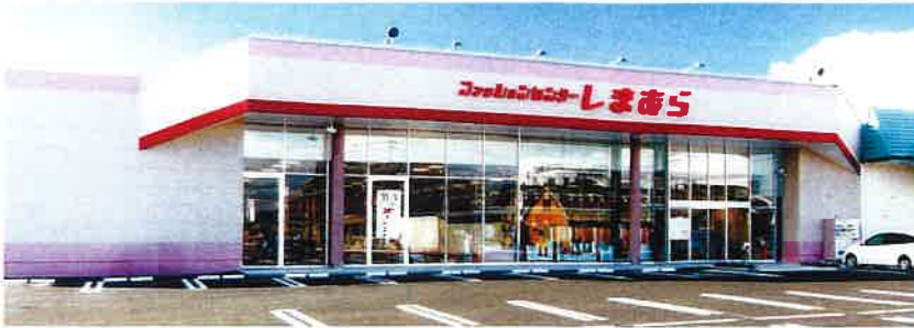
■受注先 株式会社 しまむら ■工事名 ファッションセンター しまむらびきの店 新築工事 ■竣工 平成 20 年 12 月
