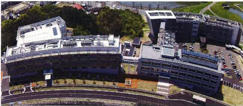
■受注先 国立大学法人 九州大学 ■工事名 九州大学(伊都)3 施設 新築その他工事 ■竣工 平成 27 年 1・2 月
