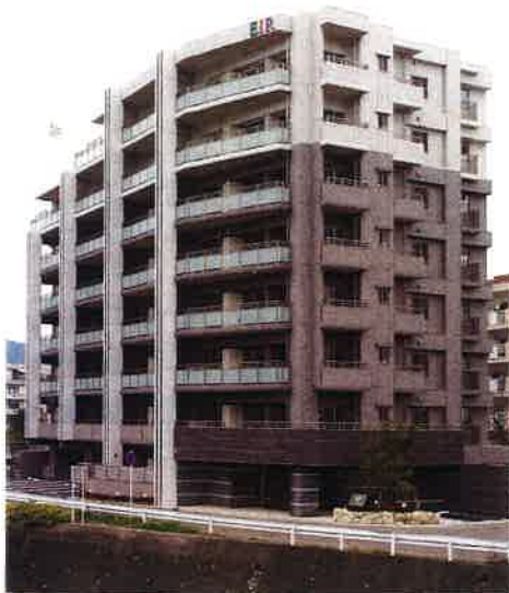
■受注先 作州商事株式会社 ■工事名 エイルマンション文教 新築工事 ■竣工 平成 29 年 12 月
