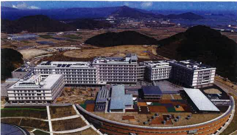
■受注先 国立大学法人 九州大学 ■工事名 九州大学(伊都)総合教育研究棟(人文社会科学系)新営工事 ■竣工 平成 30 年 2 月
