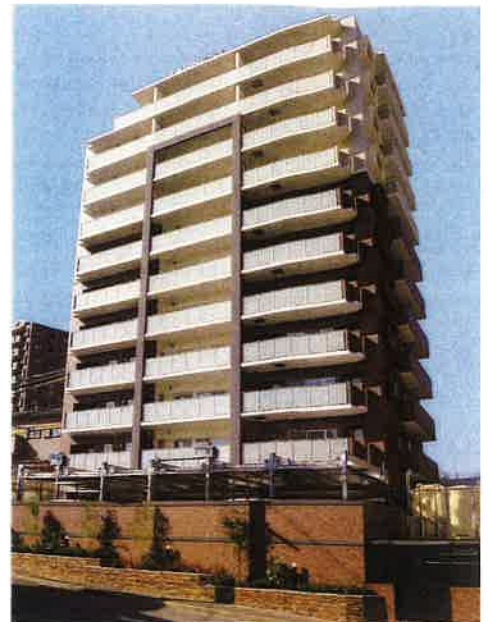
■受注先 株式会社ファミリー ■工事名 ファーネスト本原 新築工事 ■竣工 平成 26 年 11 月
