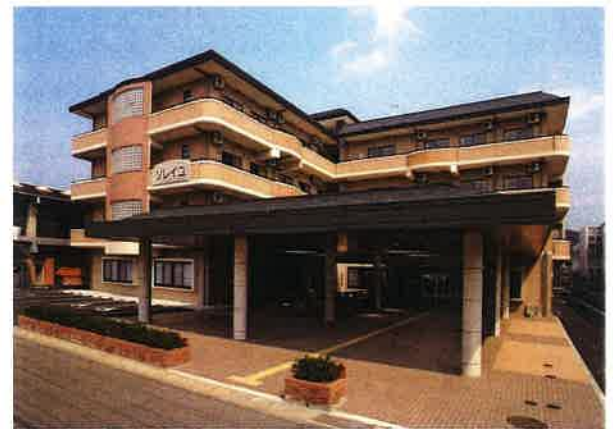
■受注先 社会福祉法人 豊寿会 ■工事名 養護老人ホームソレイユ 改築工事 ■竣工 平成 24 年 2 月
