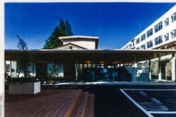
九州文化学園小中学校 平成 31 年 3 月完成
