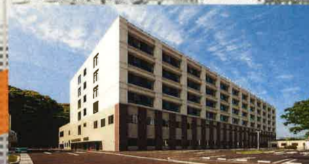
長崎川棚医療センター 平成 29 年 6 月完成
